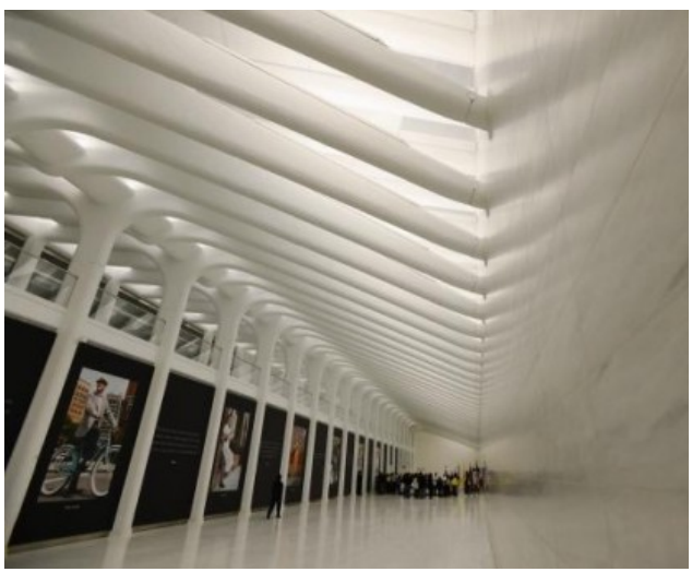
W.T.C.T.H. Underground Corridor
