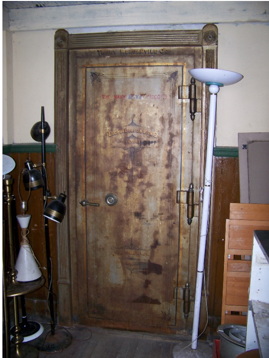
Existing safe door
