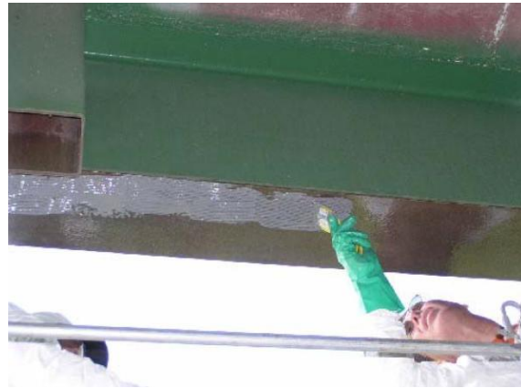
(d) Epoxy application on beam
