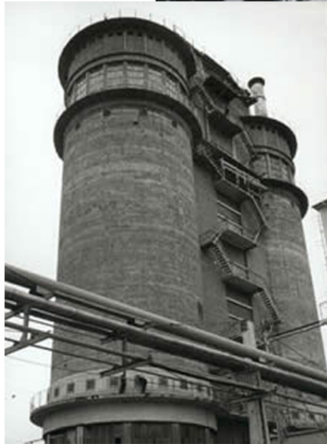
Die für das städtische Gaswerk errichteten im Jahre 1898-1899 errichteten vier Gasbehälter (Innendurchmesser: 20,5m, Höhe: 100m, Mauerstärke: Zwischenstand: 100 cm) (Aufnahme: Archiv der VAW-Gas)
